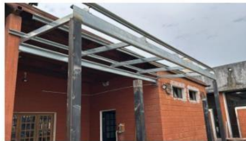
Vigas y Clavadera para techo
